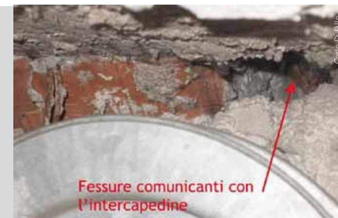
Immagine di un thermal bypass evidenziato in una struttura con intercapedine. Il flusso d'aria non entra all'interno dell'immobile, ma raffredda la muratura in corrispondenza del cassonetto dell'avvolgibile
